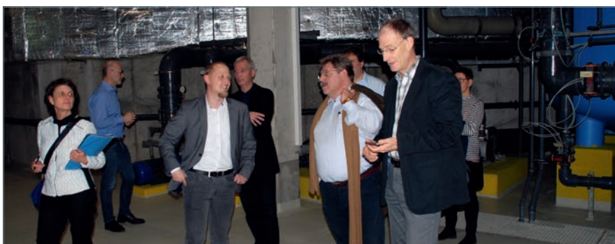
■ Abbildung 2: Der großzügige Technikkeller hinterließ einen besonders positiven Eindruck.
